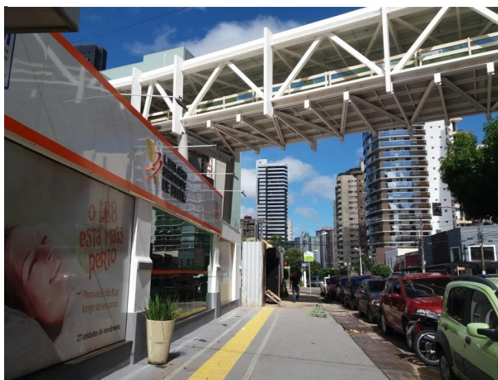
Figura 55: Passarela na Rua Boaventura da Silva
